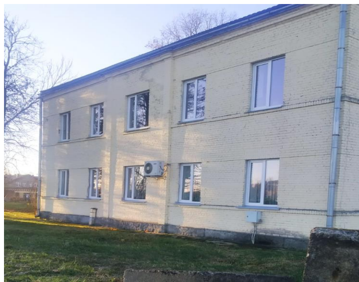
Att.Nr.2. Ēkas fasāde "B" (skat. pielikumā, sakaru nama Transporta ielā 4, Jēkabpilī, 1.stāva logu bloku shēmu)
