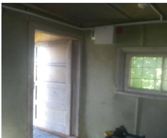
Att. Nr. 13. Skats DGA ēkas iekšā
