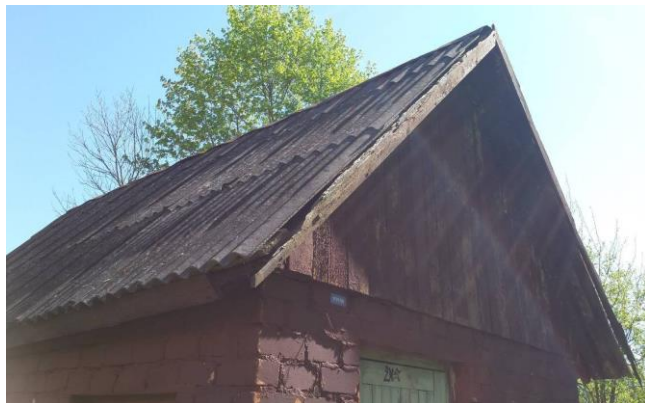
Att. Nr. 4. Skats uz DGA ēkas jumtu
