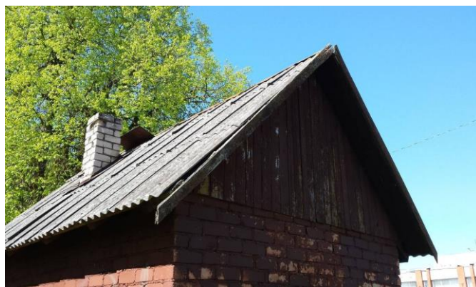
Att. Nr. 5. Skats uz DGA ēkas jumtu
