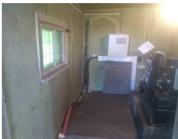
Att. Nr. 12. Skats DGA ēkas iekšā
