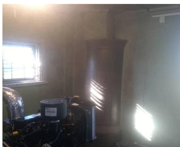
Att. Nr. 14. Skats DGA ēkas iekšā
