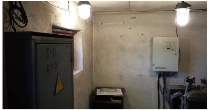
Att. Nr. 7. Skats DGA ēkas iekšā
