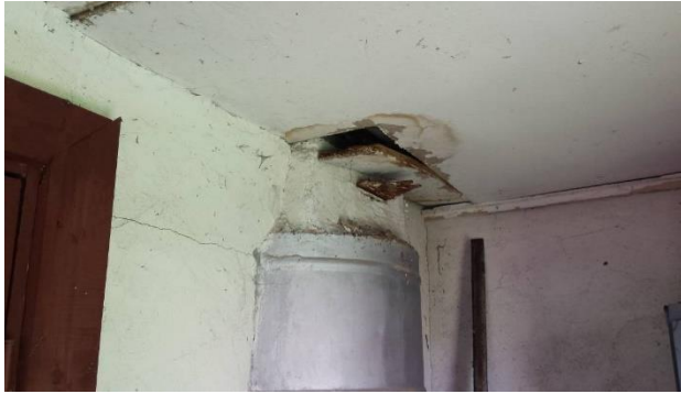
Att. Nr. 6. Skats DGA ēkas iekšā
