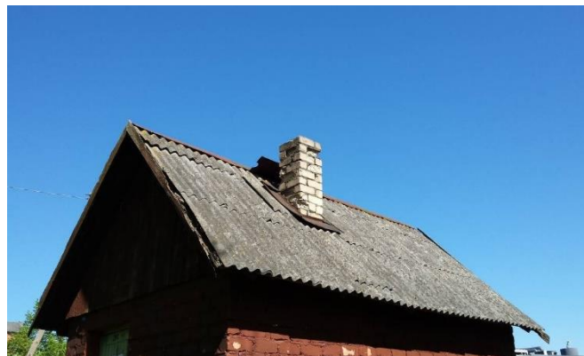
Att. Nr. 3. Skats uz DGA ēkas jumtu
