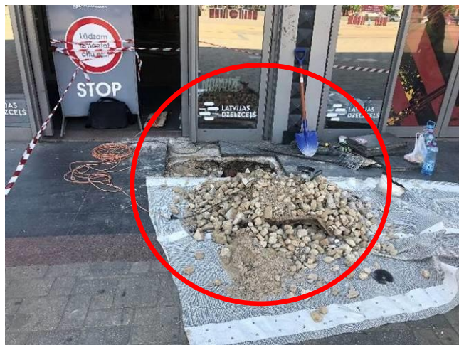
Foto Nr. 56, 57 Ieejas mezgla atsegums virs pagraba telpas (Zona 2) Nr.3 pārseguma.
