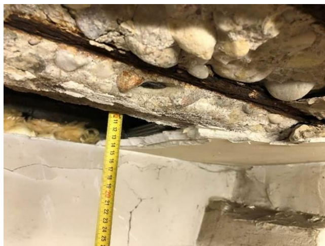
Foto Nr. 46 Monolitās pārseguma plātnes biezums 100-120mm.
