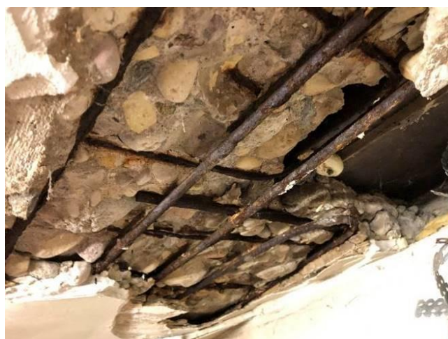
Foto Nr. 48 Nesošais stiebrojums gludstiegra Ø12mm.
