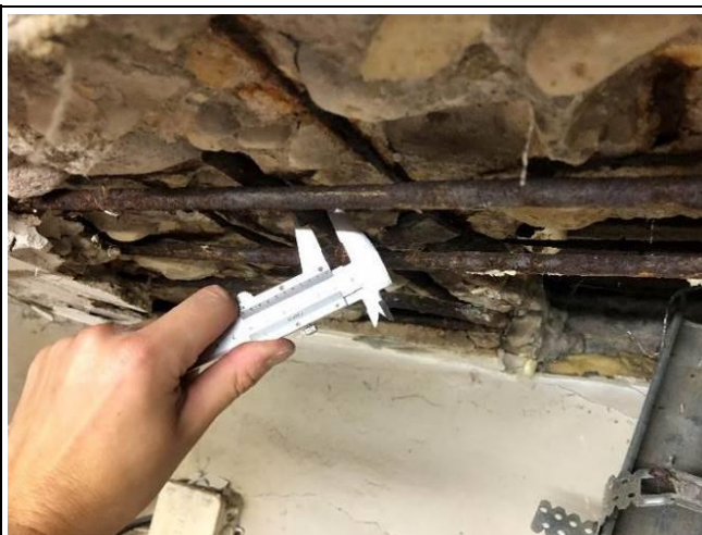
Foto Nr. 49 Nesošais stiegrojums gludstiegra Ø12mm.
