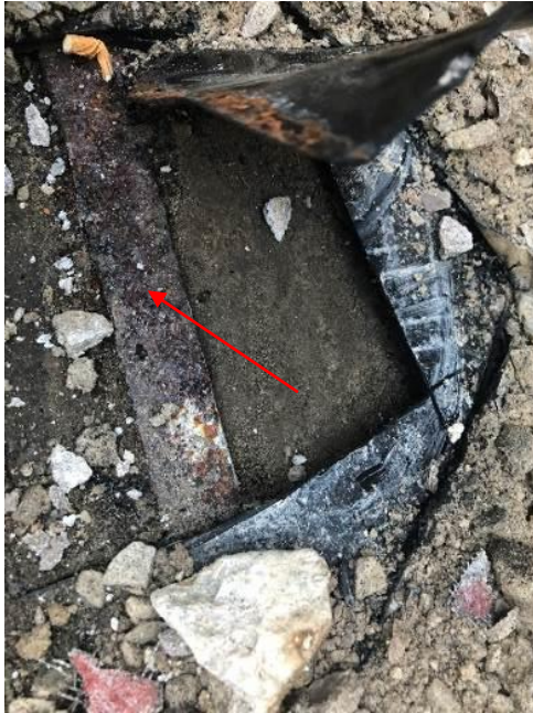
Foto Nr. 63 Pārseguma konstrukcijā redzama tērauda sija.
