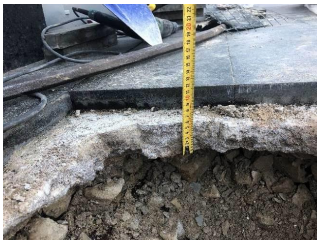
Foto Nr. 59 Nestiegrots betona klons b-60mm.
