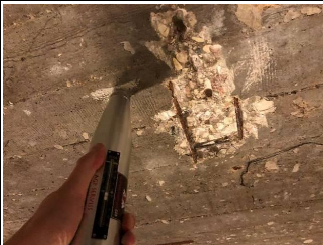
Foto Nr. 26 Betona cietības pārbaude ar šmita āmuru – 45MPa.
