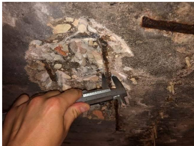
Foto Nr. 8 Nesošais stiegrojums Ø12mm.
