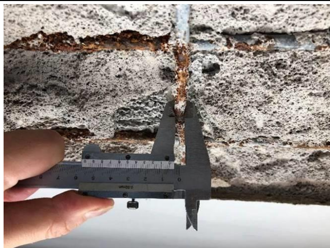
Foto Nr. 71 Konstruktīvā šķērsvirziena stiegrojums Ø6mm.
