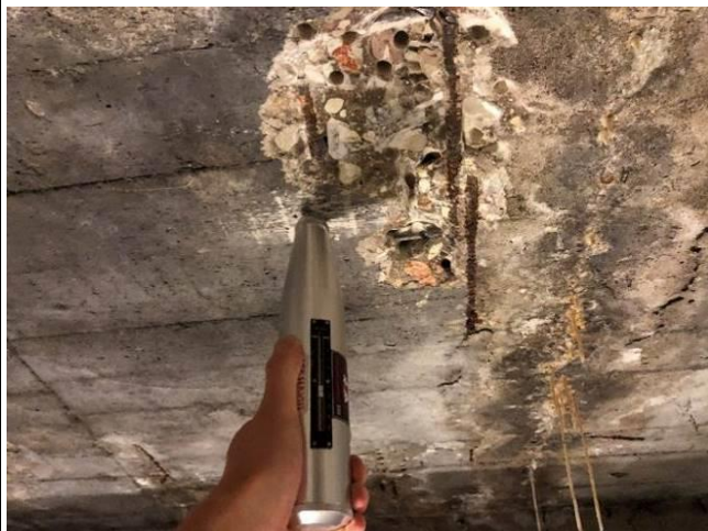
Foto Nr. 7 Betona cietības pārbaude ar šmita āmuru – 45MPa.
