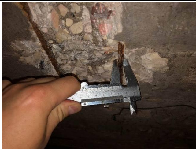
Foto Nr. 27 Nesošais stiegrojums gludstiegra Ø8mm.
