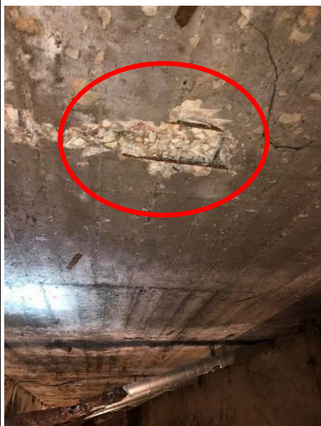
Foto Nr. 24 Atsegums Nr.3, atsegts apakšējais stiegrojums.
