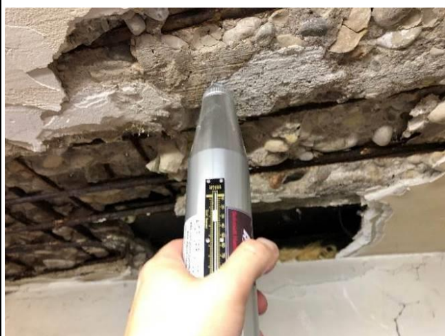
Foto Nr. 53 Betona cietības pārbaude ar šmita āmuru – 25MPa
