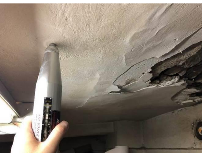
Foto Nr. 54 Betona cietības pārbaude ar šmita āmuru – 25MPa..
