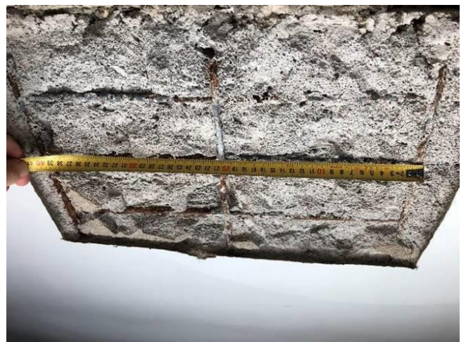
Foto Nr. 70 Konstruktīvā šķērsvirziena stiegrojuma solis 200mm.
