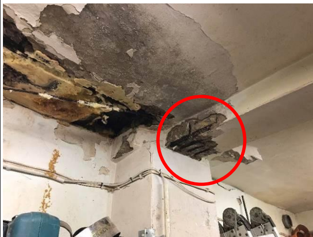
Foto Nr. 39 Pārseguma dz.betona rīgelis, kuram veikts atsegums.
