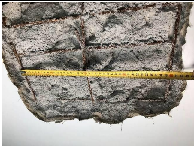
Foto Nr. 86 Konstruktīvā šķērsvirziena stieģrojuma solis 200mm.
