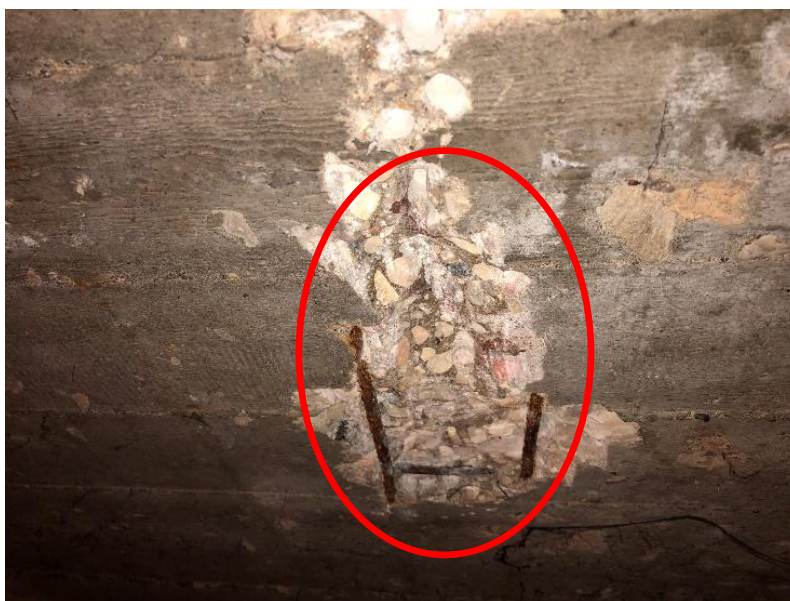
Foto Nr. 25 Atsegums Nr.3, atsegts apakšējais stiegrojums.
