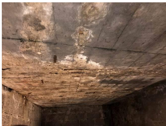
Foto Nr. 6 Pārseguma konstrukcija atseguma Nr.1 zonā.
