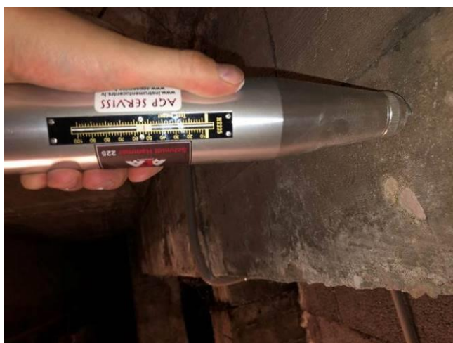
Foto Nr. 20 Betona cietības pārbaude ar šmita āmuru – 50MPa.
