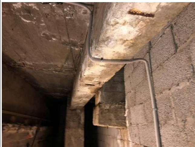
Foto Nr. 16 Pārseguma dz.betona sija, kurai veikts atsegums.
