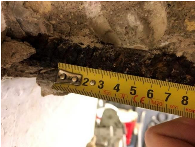
Foto Nr. 35 AIII klases stiegra, t=12\text{mm} .
