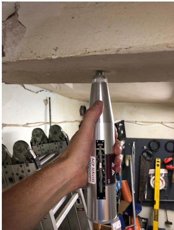
Foto Nr. 41 Betona cietības pārbaude ar šmita āmuru – 35MPa.
