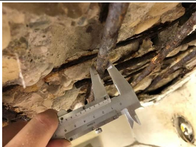
Foto Nr. 50 Nesošais stiegrojums gludstiegra Ø12mm..
