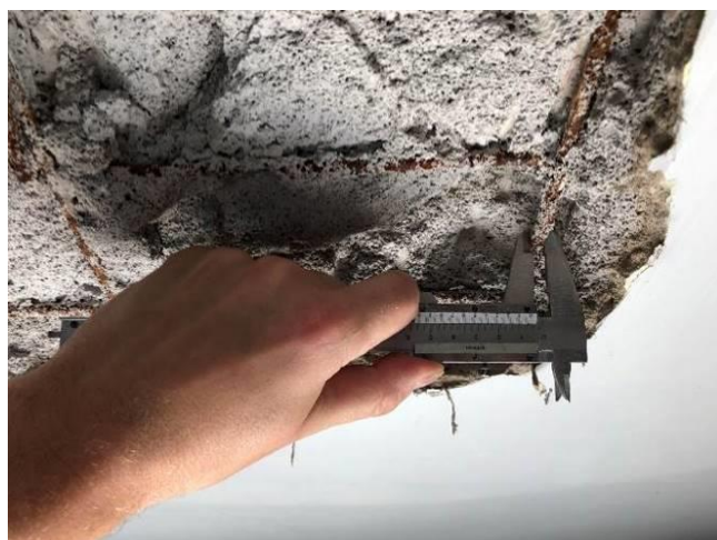
Foto Nr. 87 Konstruktīvā šķērsvirziena stieģrojums Ø6mm.
