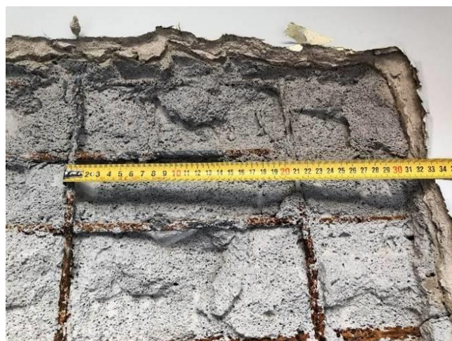
Foto Nr. 78 Konstruktīvā šķērsvirziena stiegrojuma solis 200mm.
