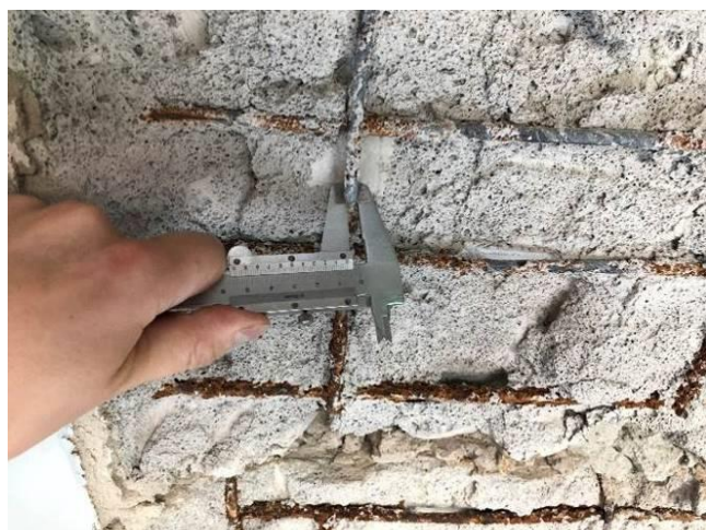
Foto Nr. 79 Konstruktīvā šķērsvirziena stiegrojums Ø6mm.
