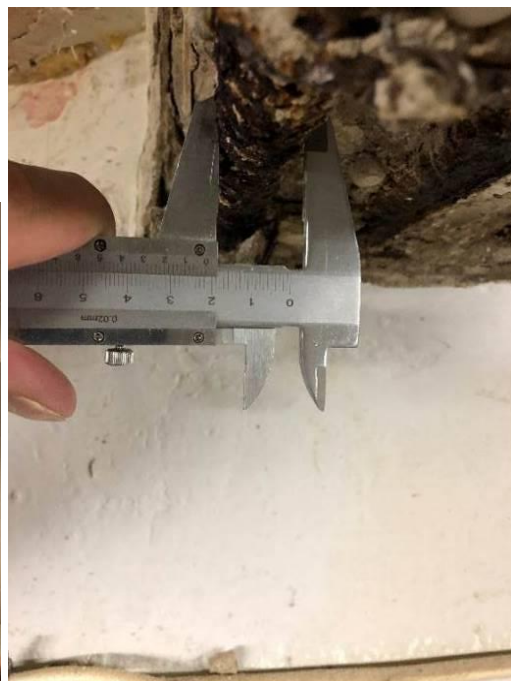
Foto Nr. 40 Steigras 4x \varnothing 22mm.
