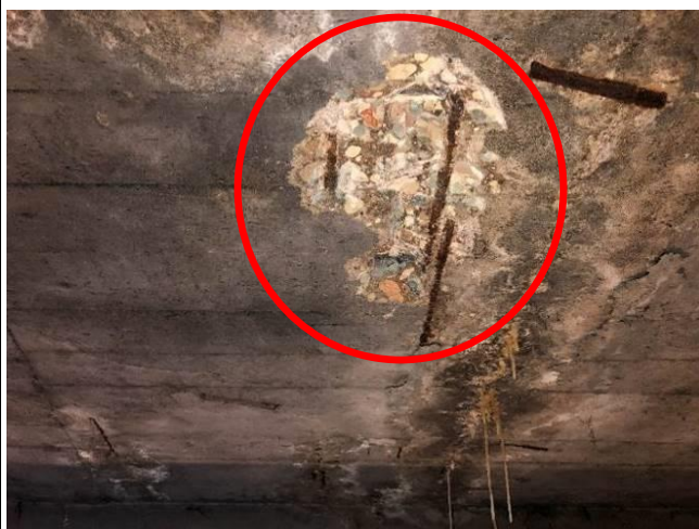
Foto Nr. 5 Atsegums Nr.1, atsegts apakšējais stiegrojums.
