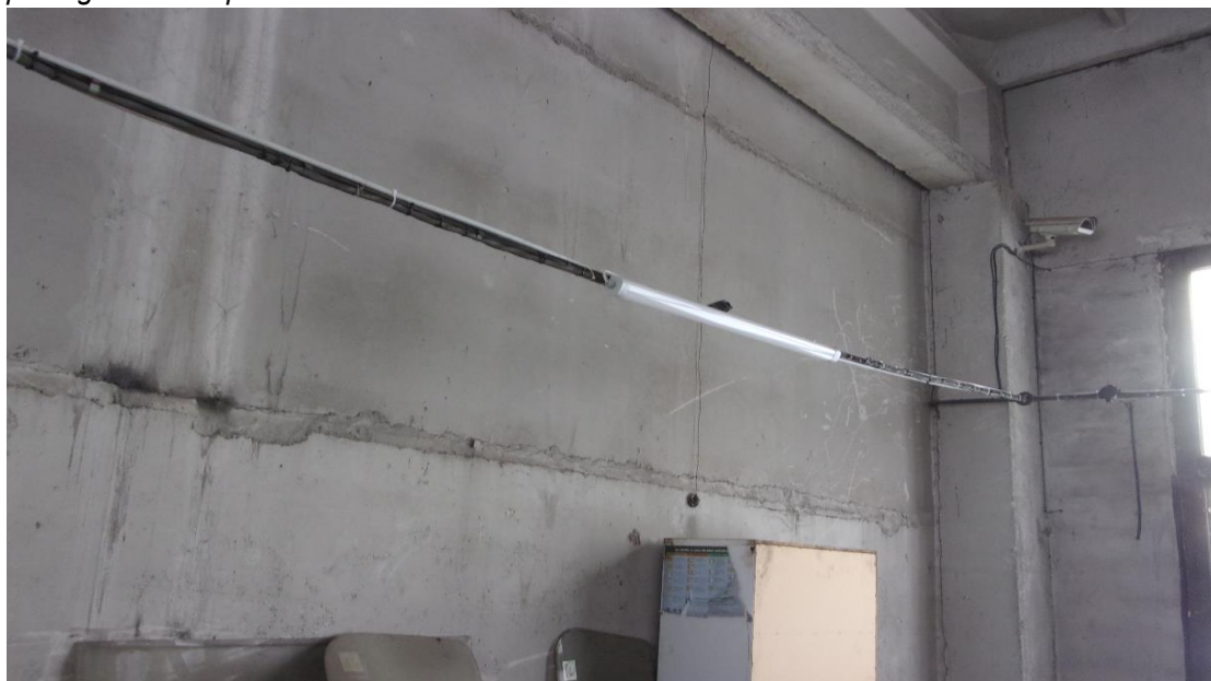
Attēls .Nr.4. Skats uz esošo apgaismojuma lampu.
