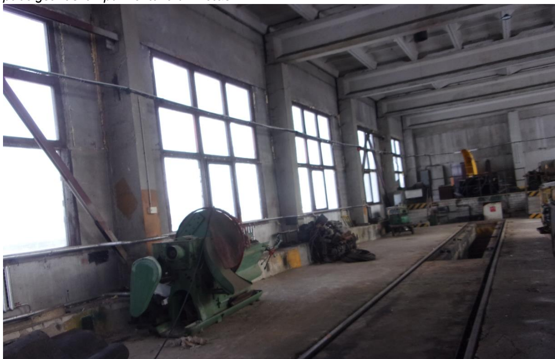
Attēls .Nr.3. Ēku iekštelpa.
