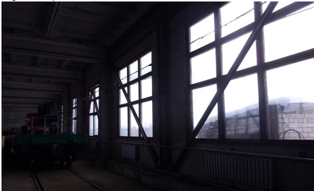
Attēls .Nr.2. Ēku iekštelpa.
