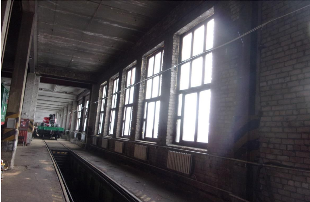
Attēls .Nr.1. Ēku iekštelpa.
