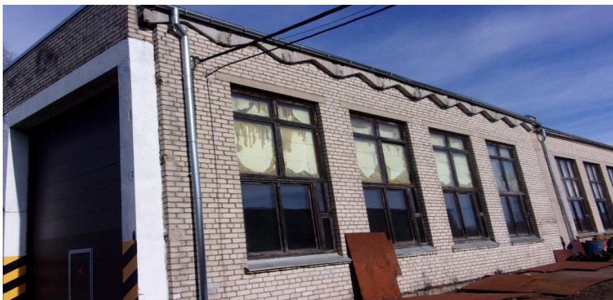
Att.Nr.1. Ēku Stacijas ielā 27, Rēzeknē fasāde (fotofiksācijas virziens saskaņā ar “Ēku vienkāršotas pārbūves shēmu”)
