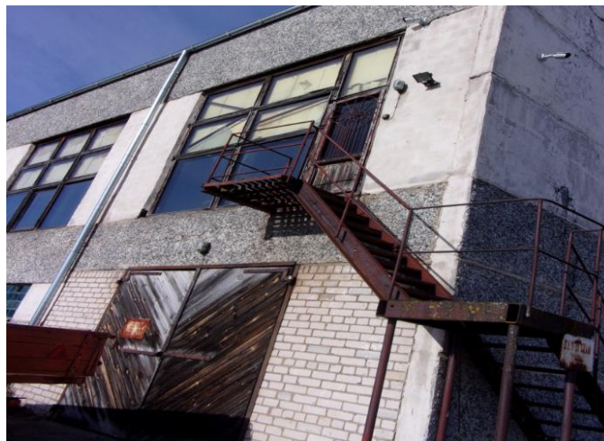
Att.Nr.5. Ēku Stacijas ielā 27, Rēzeknē fasāde (fotofiksācijas virziens saskaņā ar “Ēku vienkāršotas pārbūves shēmu”)
