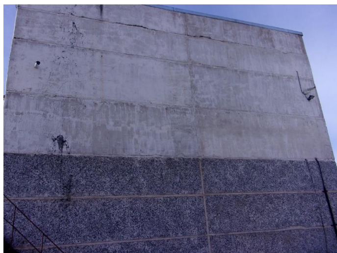
Att.Nr.6. Ēku Stacijas ielā 27, Rēzeknē fasāde (fotofiksācijas virziens saskaņā ar “Ēku vienkāršotas pārbūves shēmu”)
