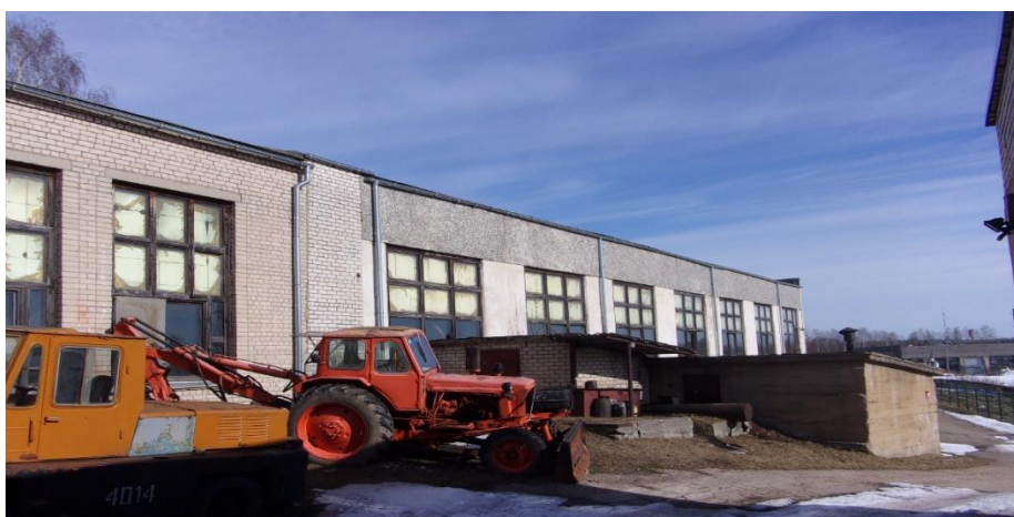
Att.Nr.3. Ēku Stacijas ielā 27, Rēzeknē fasāde (fotofiksācijas virziens saskaņā ar “Ēku vienkāršotas pārbūves shēmu”)
