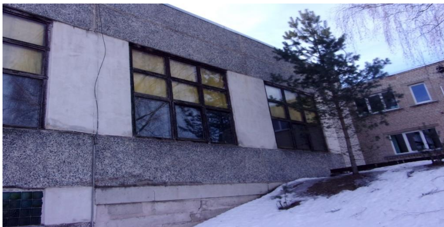
Att.Nr.9. Ēku Stacijas ielā 27, Rēzeknē fasāde (fotofiksācijas virziens saskaņā ar “Ēku vienkāršotas pārbūves shēmu”)
