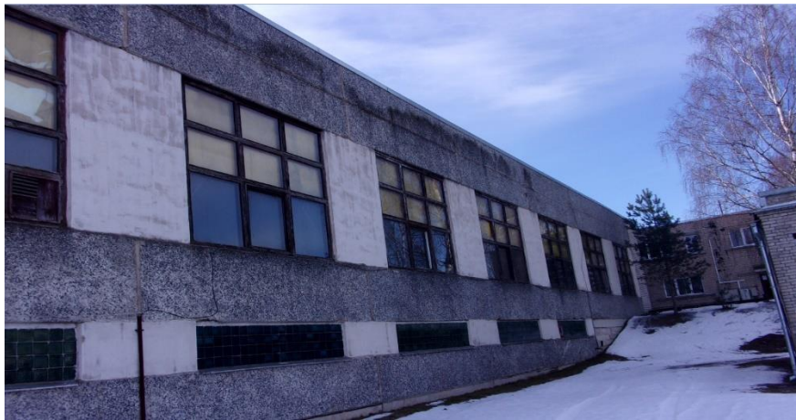
Att.Nr.8. Ēku Stacijas ielā 27, Rēzeknē fasāde (fotofiksācijas virziens saskaņā ar “Ēku vienkāršotas pārbūves shēmu”)
