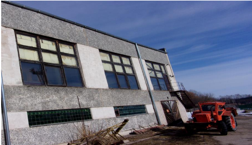
Att.Nr.4. Ēku Stacijas ielā 27, Rēzeknē fasāde (fotofiksācijas virziens saskaņā ar “Ēku vienkāršotas pārbūves shēmu”)
