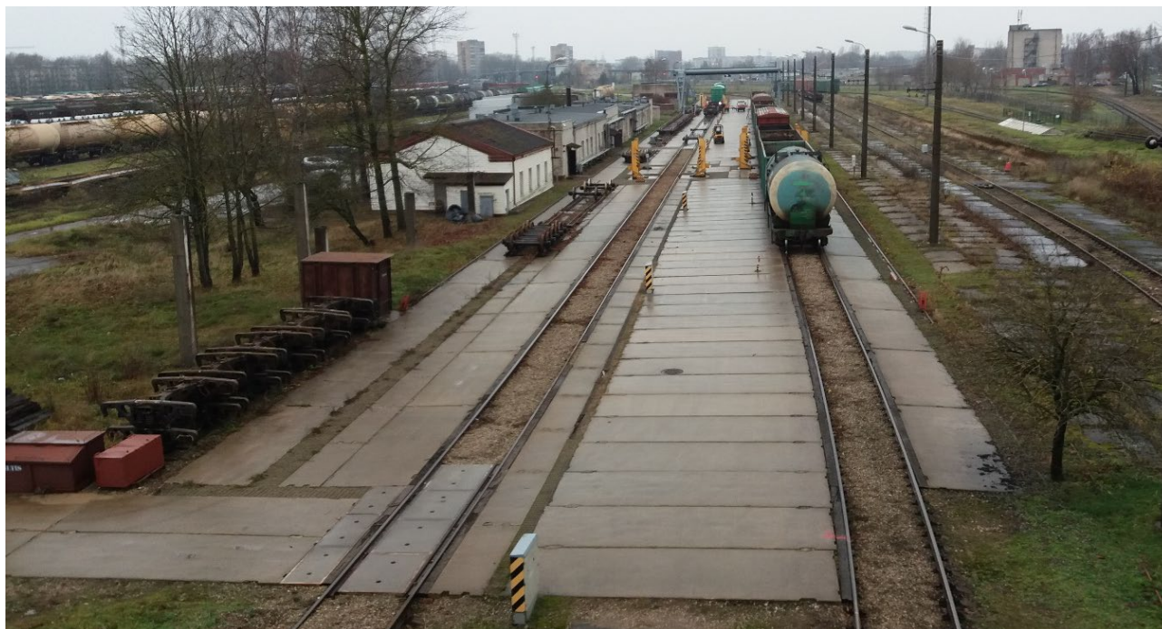
1. att. Specializētais laukums vagonu kārtējām atkabes remontam Šķirotavas stacijā
