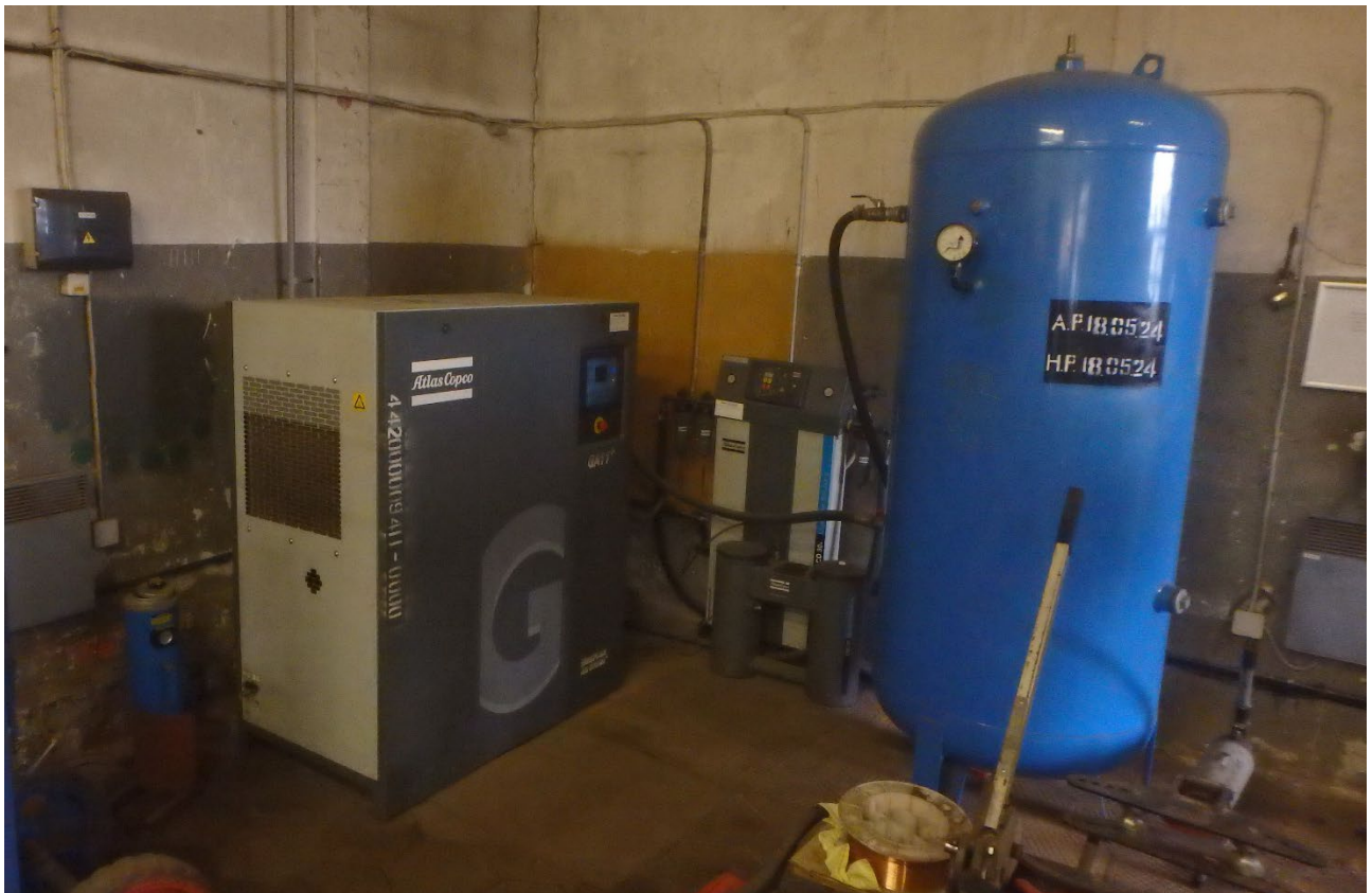
5. att. Kompresors GA11+P A 8.5 A ar vertikālo resīveru. SAP Nr. 442000009411-0000
