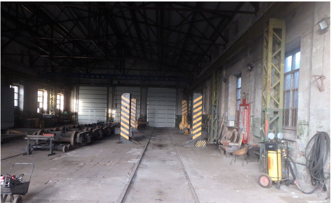
2. att. Specializētais laukums vagonu kārtējām atkables remontam Liepājas stacijā (iekštelpā)
