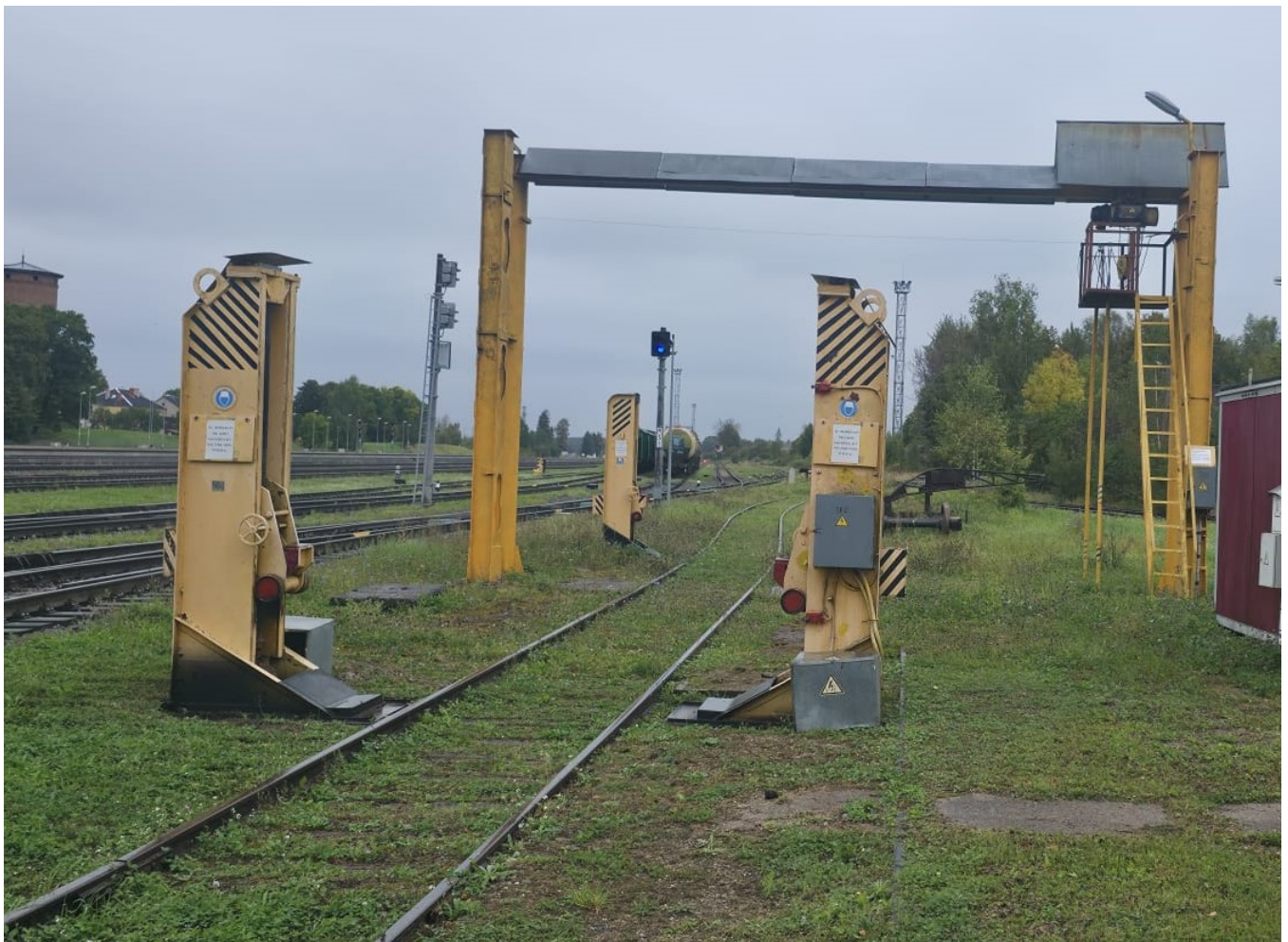
1. att. Specializētais laukums vagonu kārtējām atkabes remontam Krustpils stacijā.
