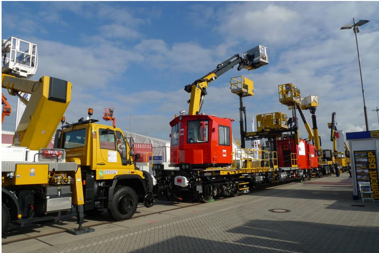
22.attēls Būvniecības vilciens un tehnika darbam staciju un pārbrauktuvju teritorijās. Avots: LDZ
