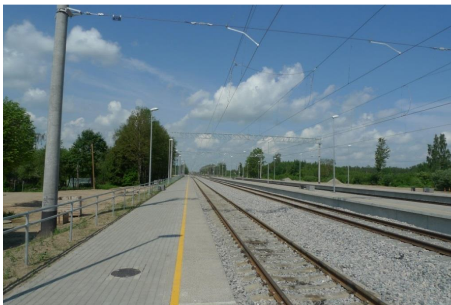
2. attēls: Jauna gaisa kontaktvadu sistēma posmā Skrīveri – Aizkraukle. Avots:LDZ.
