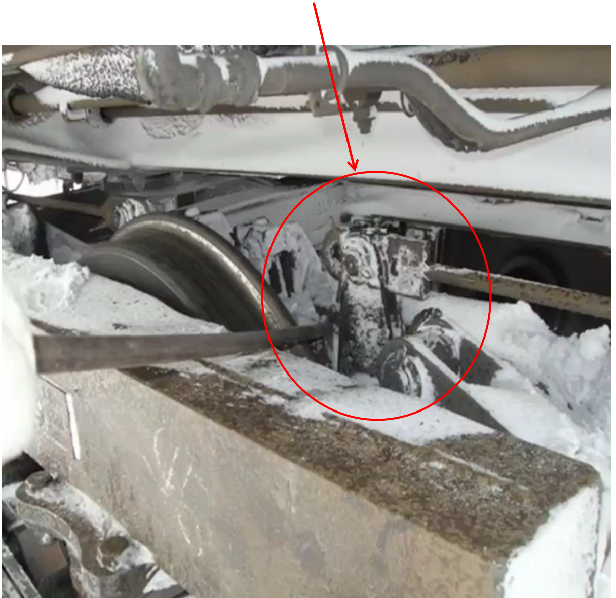
Рисунок Б.2 – Очистка затяжки вертикальных рычагов тележки, в местах сливов из умывальных чаш и водоотводных труб под котельными отделениями, в соответствии с п.п. 2.1.2 и 3.1.2
